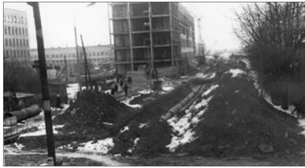
Строительство административного корпуса и нового цеха завода КРИЗО. Фото Юрия Алексеевича Прокошева.
